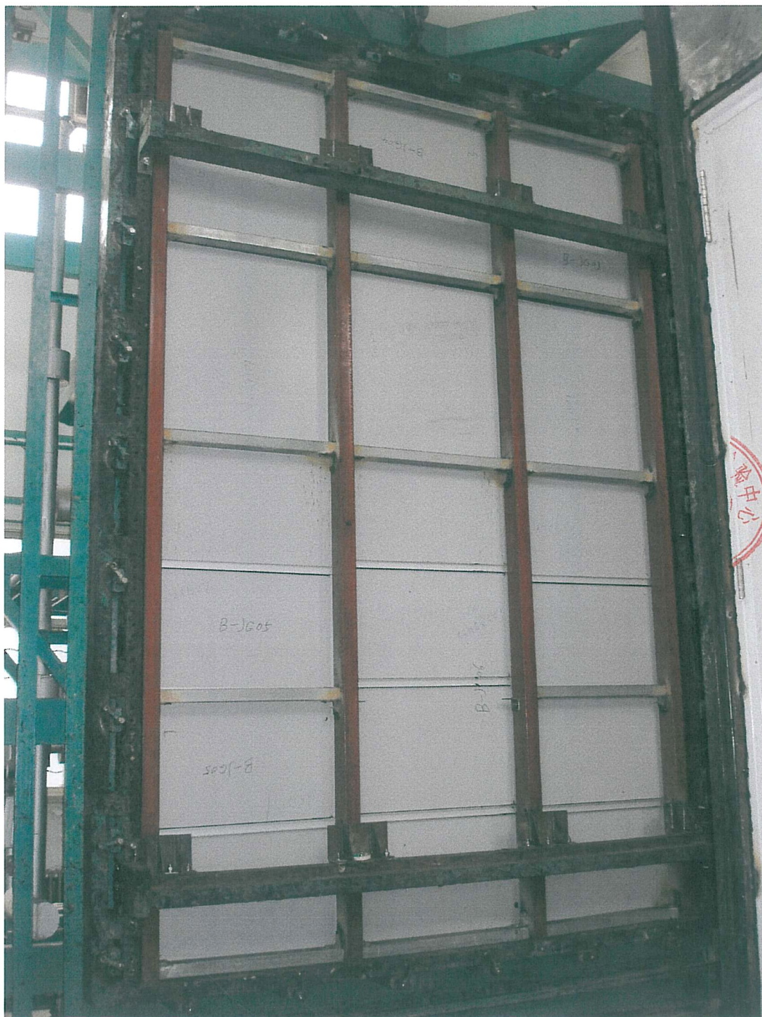
送检样品钢龙骨 A2 级防火铝复合板幕墙安装照片
